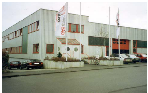
Standort: 74 321 Bietigheim-Bissingen, Rosenstr. 31 1988 Anbieter: Rommel Bau-Unternehmer Nutzer: DWS-Wärmesysteme GmbH Beschreibung: Vermietung von Hallen-Flächen
