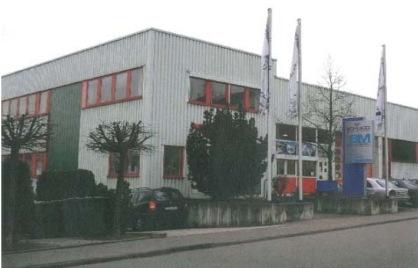
Standort: 74 321 Bietigheim-Bissingen, Rosenstr. 31 2008 Anbieter: Heinz und Gerhard Rommel GbR Nutzer: Porsche Engineering Service Beschreibung: Halle zur Lagerung und Bearbeitung von Werkteilen
