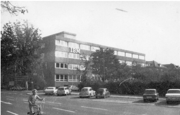
Standort: 74 076 Heilbronn, Karlstraße 68 1972 Anbieter: IBM-Deutschland Nutzer: DLW AG, Mehne Stahlbau, Finanzamt Heil Beschreibung: Büro-Untervermietung
